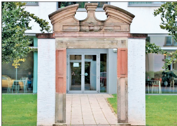
Abbildung 19: ...und was von ihnen heute noch übrig ist: der Eingangsbogen, der sich zwar nicht mehr an seinem initialen Platz befindet.
