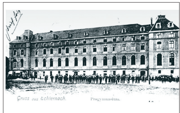
Abbildung 20: Postkarte des Zentralgebäudes der ehemaligen Echternacher Infanteriekasernen im späten 19. / frühen 20. Jahrhundert, nach der Umwandlung in ein Gymnasium 1867.
