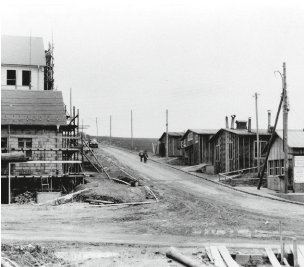
Pavillon Garde und die Bauarbeiterunterkünfte
